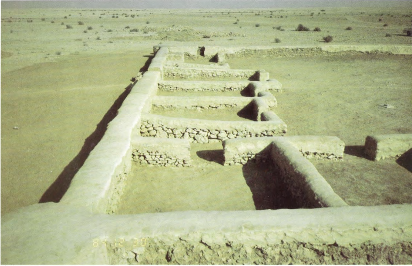
مروب - الجانب الشمالي للقلعة بعد الإنتهاء من أعمال الترميم
